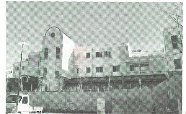
完成間近の「子ども自立生活支援センター（仮称）」
